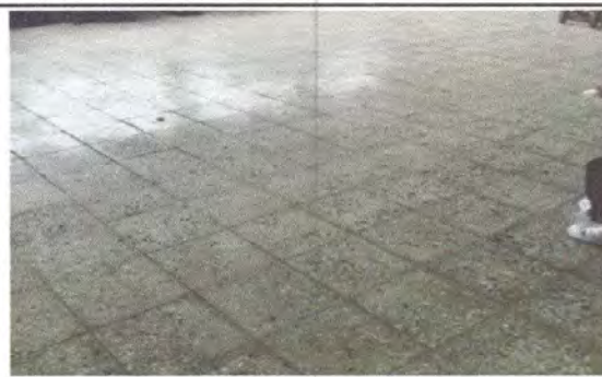
Foto 2: Sustitución de Piso de granito por piso ceramico
