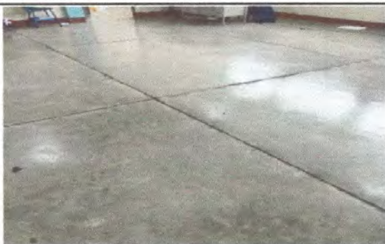
Foto 1: Sustitución de Piso de torta de concreto por piso ceramico
