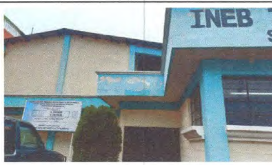
Foto 4: Pintura en muros exteriores e interiores
