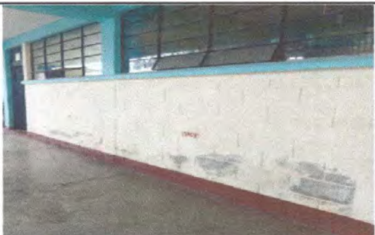
Foto 3: Pintura en muros exteriores e interiores
