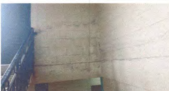
Foto 6: Pintura en muros exteriores e interiores
