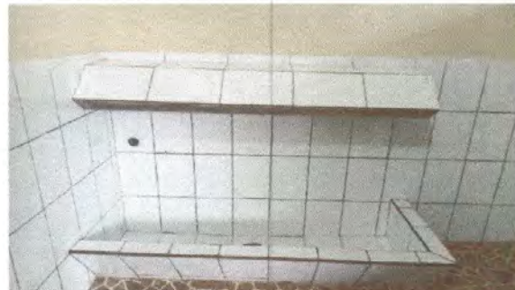
Foto 4: Sustrucción de mingitorio
